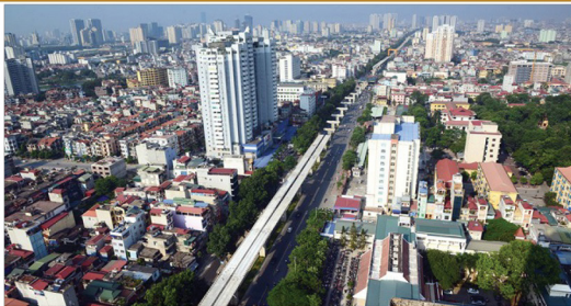
↑ ĐƯỜNG SẮT ĐÔ THỊ CÁT LINH – HÀ ĐÔNG / OVERHEAD RAILWAY CAT LINH – HA DONG
